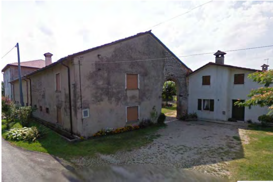
n. 2- lato ovest
