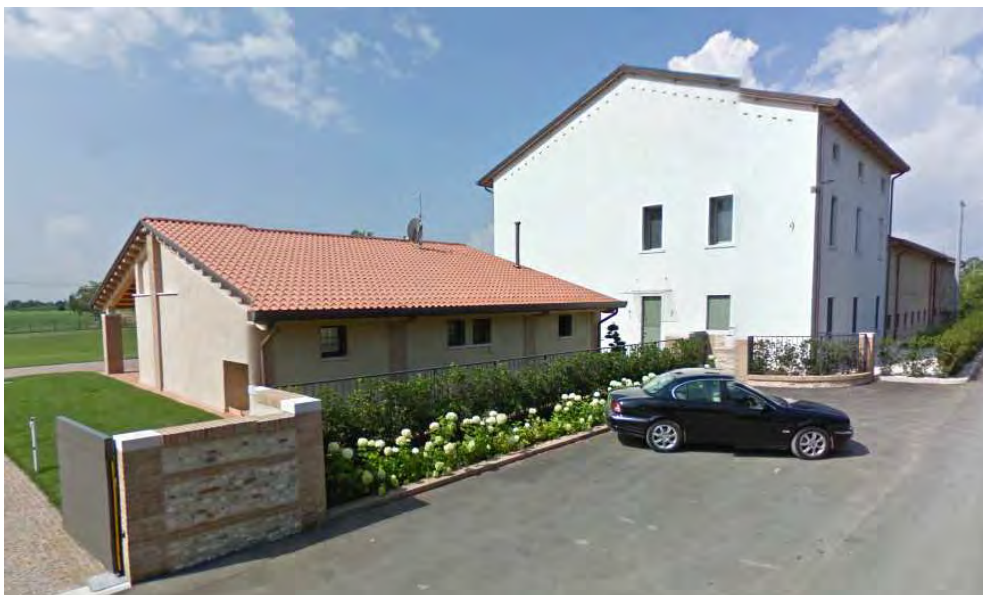
n. 4 – lato est
