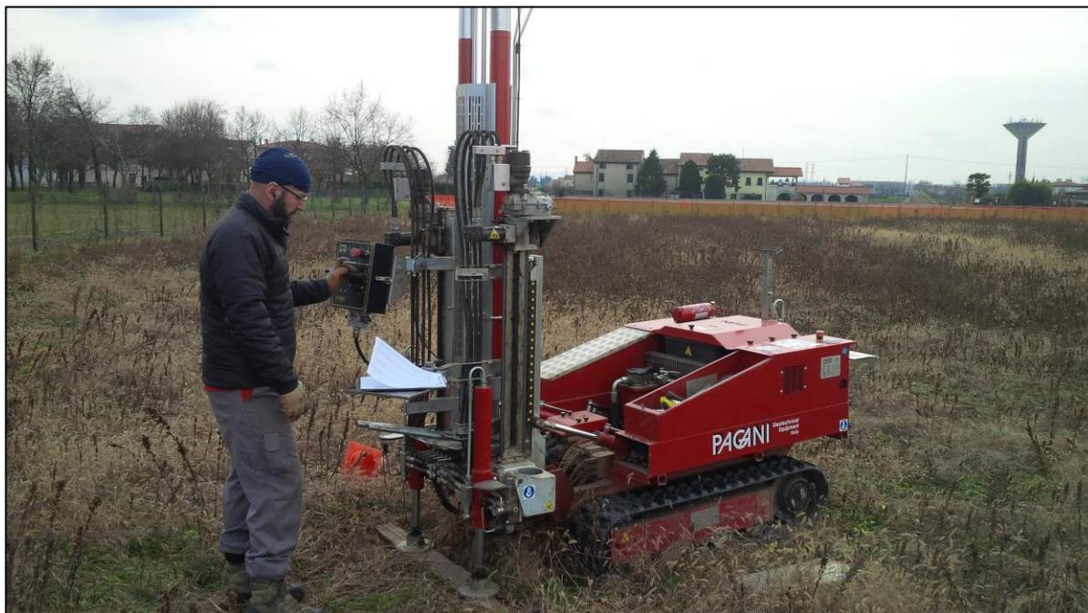
*Foto n°1: Visione panoramica del cantiere durante l'esecuzione della prova penetrometrica DPSH 1*
