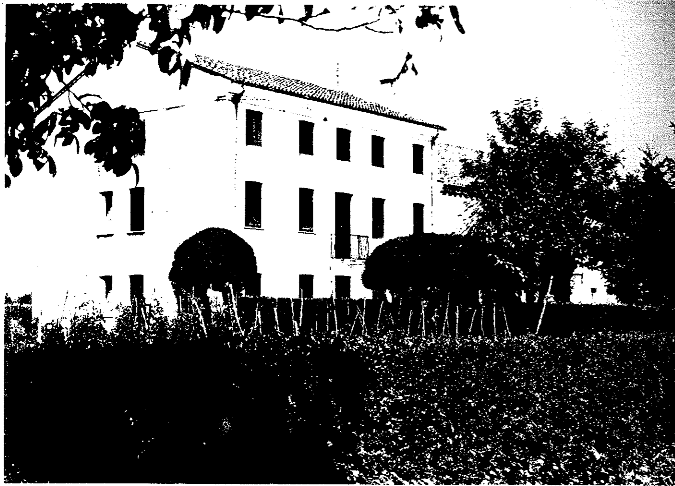
n. 1 - Vista d'insieme da sud-ovest
