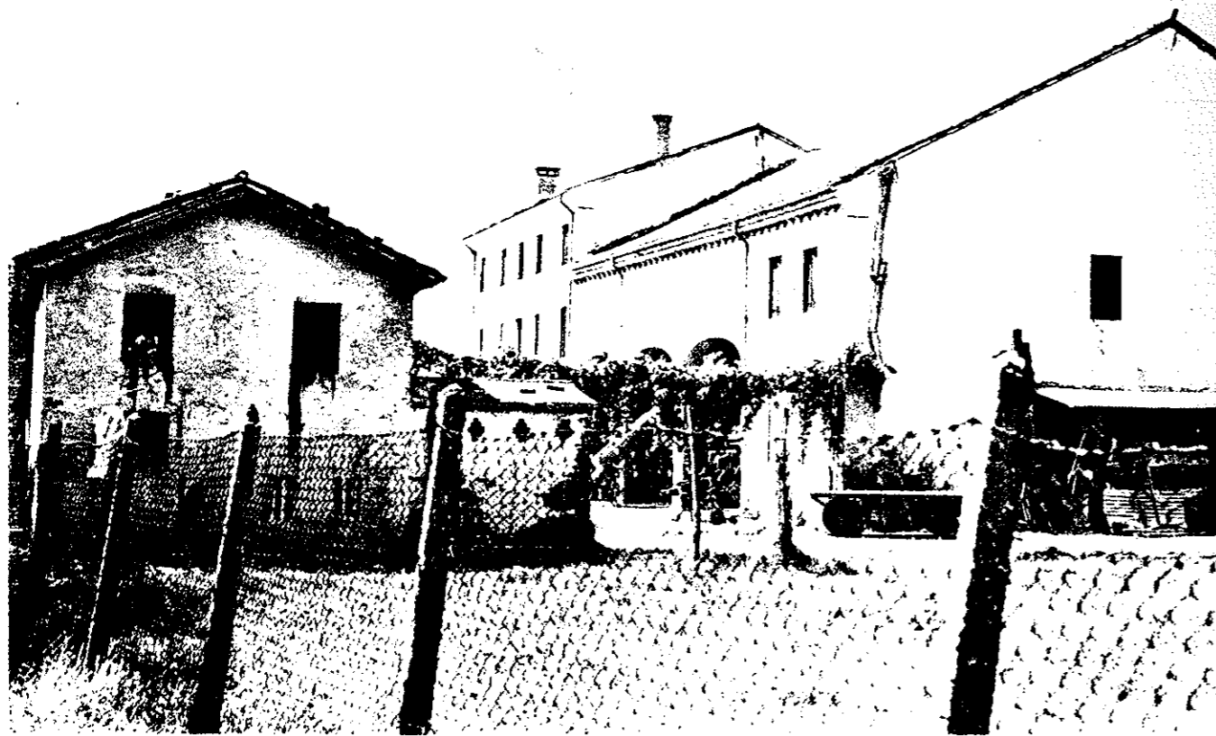
n. 2 - Vista d'insieme da sud-est
