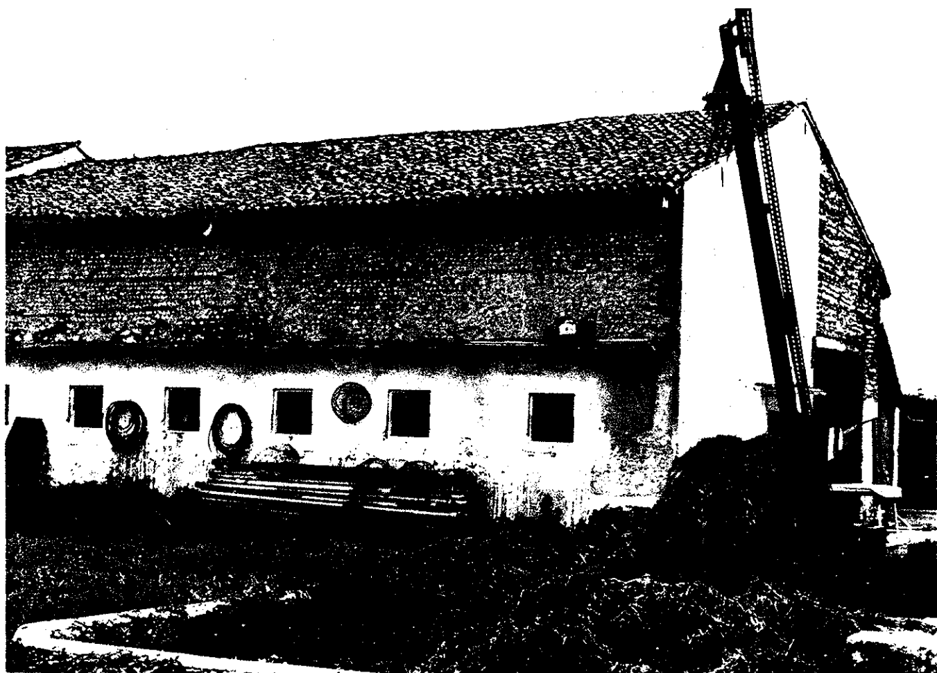
n. 2 - Facciata posteriore
