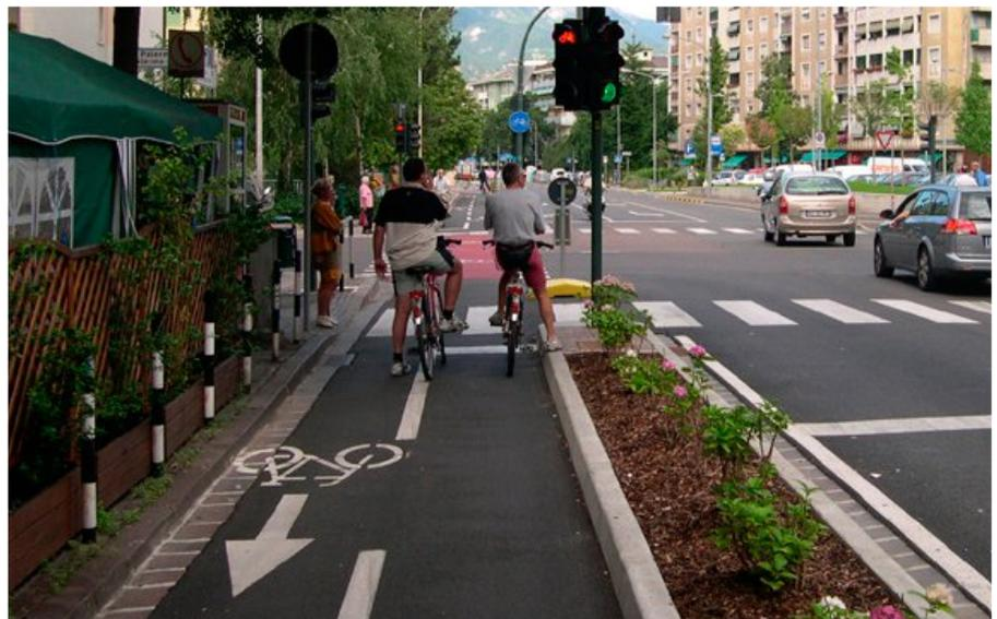
*Esempio di realizzazione di pista ciclabile in sede propria separata dalla carreggiata destinata ai veicoli a motore da uno spartitraffico fisicamente invalicabile della larghezza di metri 0,50*
