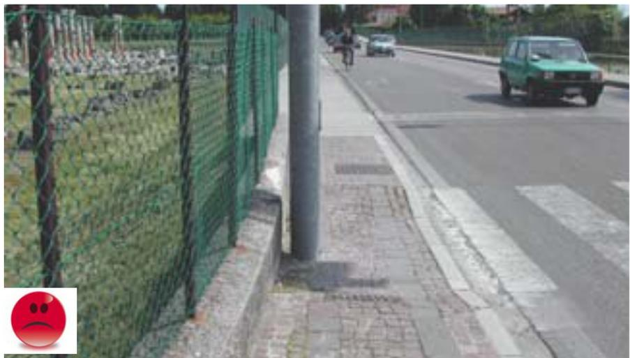
*Esempio di posizionamento NON corretto di palo sul marciapiede in corrispondenza di un attraversamento pedonale*
