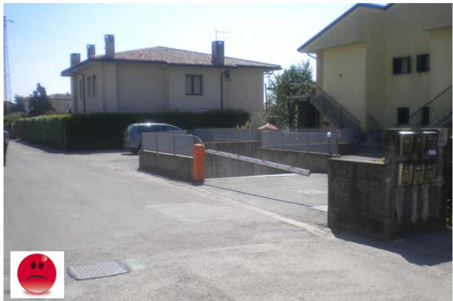
*Esempio non corretto di realizzazione di una rampa parallela alla strada.*
