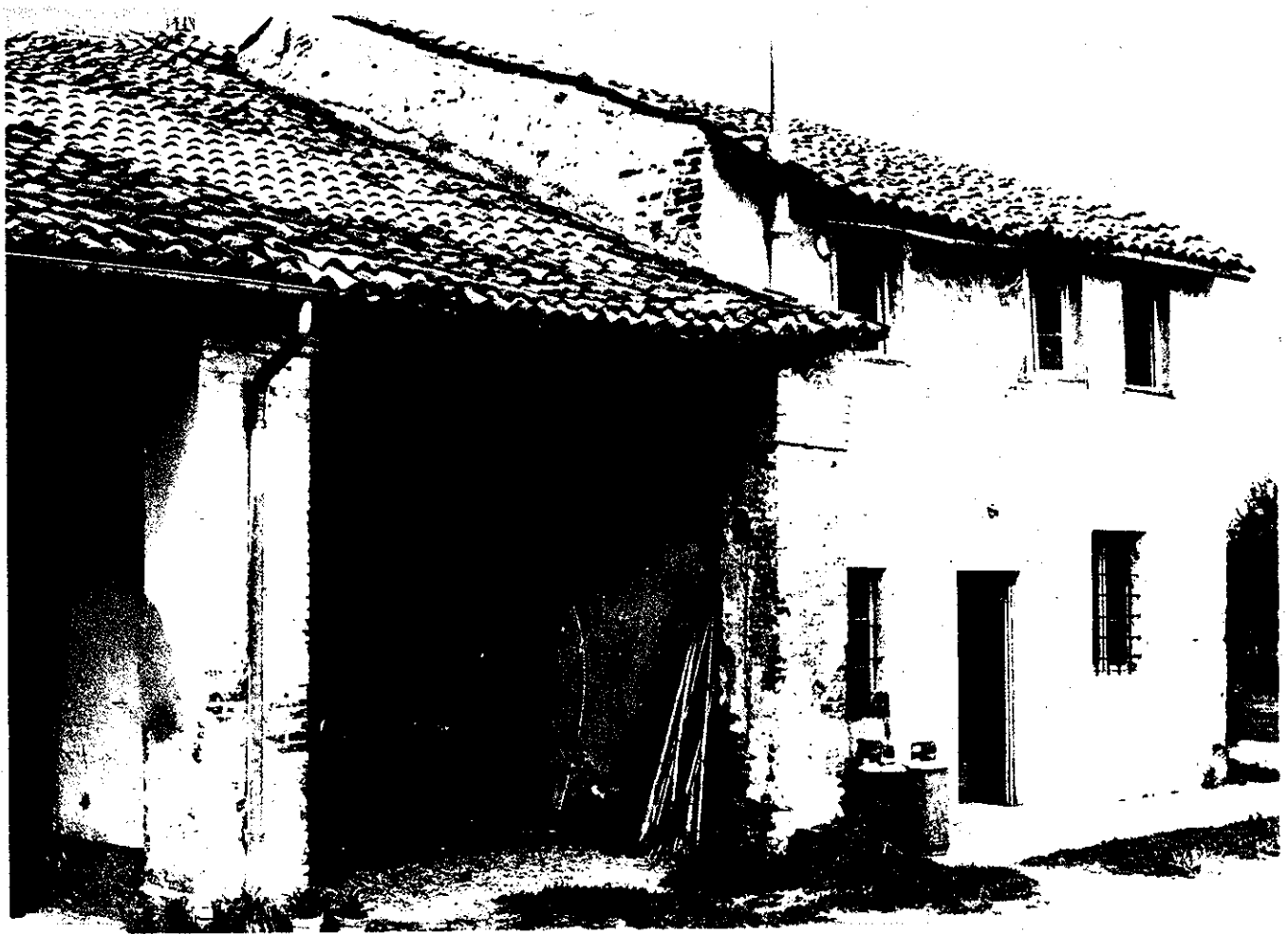
n. 1 - Facciata principale - lato sud
