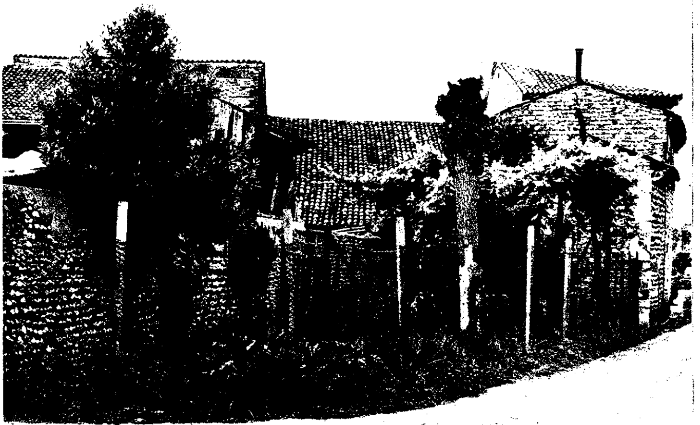
n. 1 - Veduta parziale da sud-est
